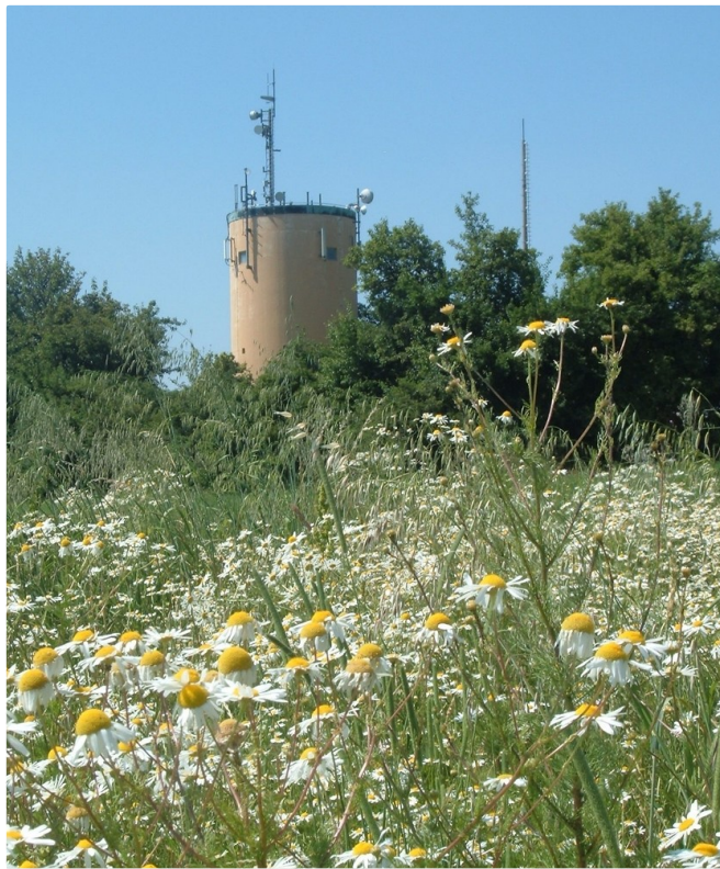
Wasserturm (01.10.2015, VGN © VGN GmbH)
