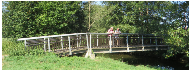
Brücke vor Buckenhof (01.10.2015, VGN © VGN GmbH)
